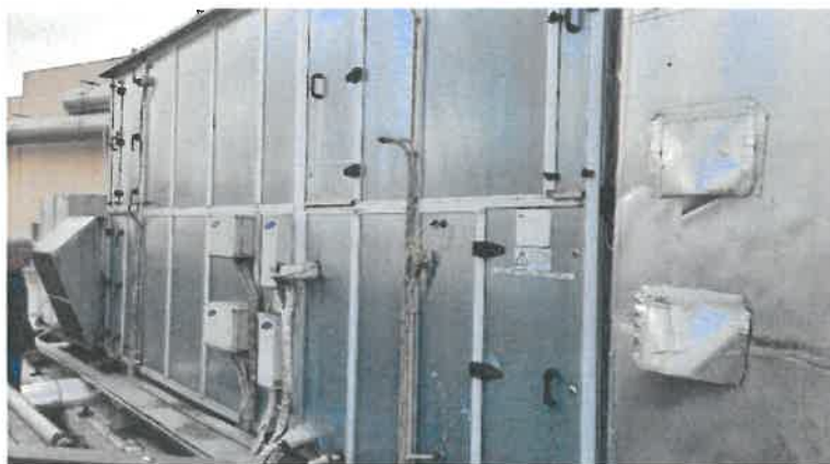
Slika 1: Pogled na klimat za prezračevanje šole postavljen na strehi.
