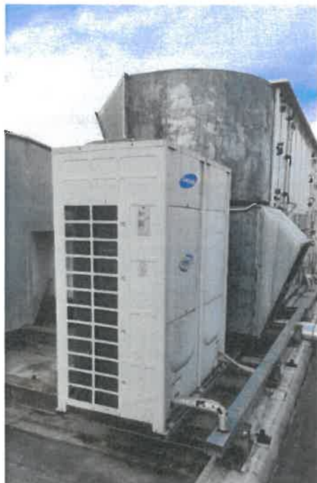
Slika 2: Toplotna črpalka in klimat za hlajenje in ogrevanje zraka OŠ Markovci 11.000 m 3 /h.
